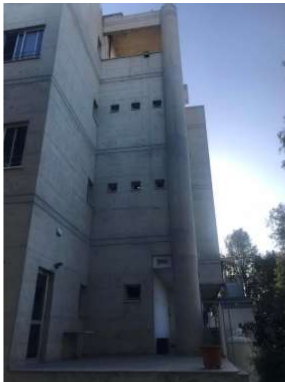
Σχήμα 7: Βορειοανατολική Όψη Κτηρίου
